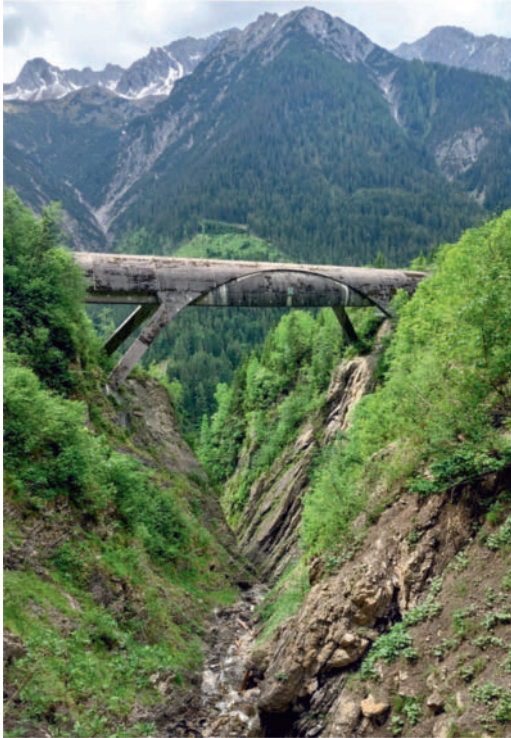
Rohrtunnel bei Bsclabs
